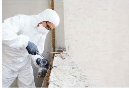
Ouvrages & zones de construction
