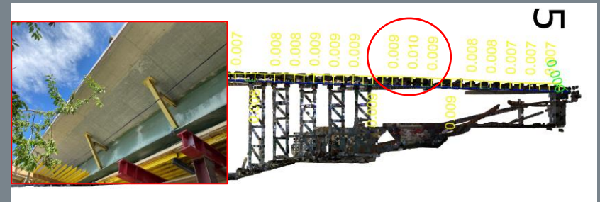
Dalle rebétonnée et désétayée : poutre avec contreflèche résiduelle de 10mm
