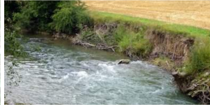
Erosion des berges
